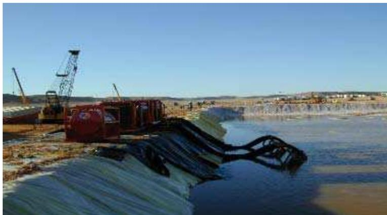
Bassin d'eau avec installation de deux pompes haute pression de lutte contre l'incendie
