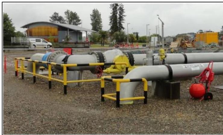
**Figure 27 : Arceaux de protection visant à protéger les canalisations**
