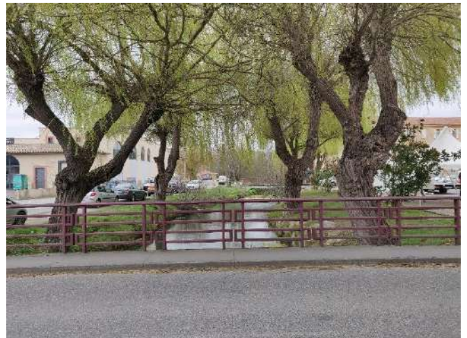
Vue amont du canal en centre-ville (vers la Save)
