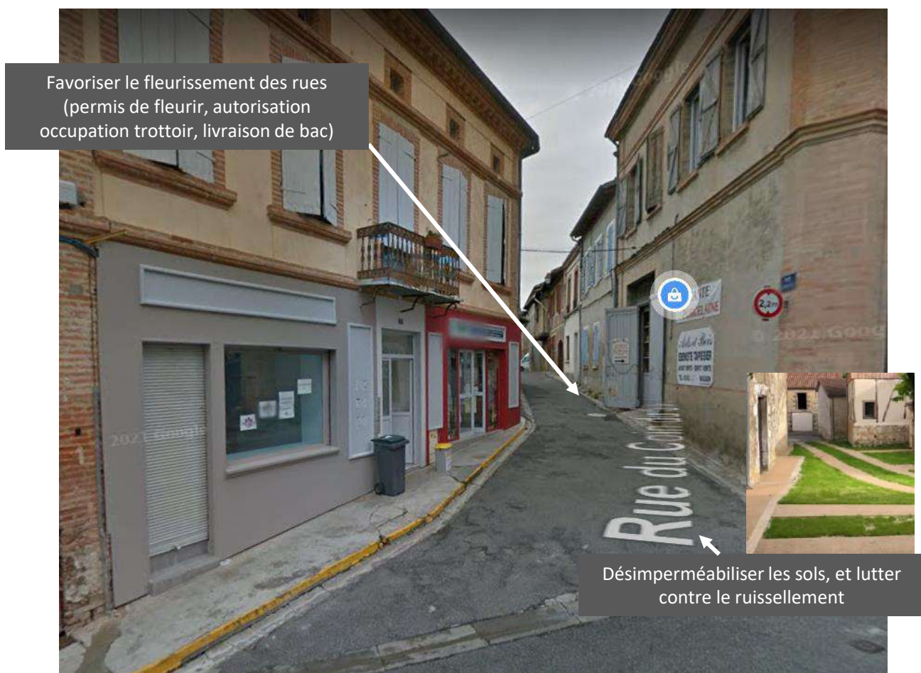
Expérimenter la végétalisation de la rue du coin du Sac
