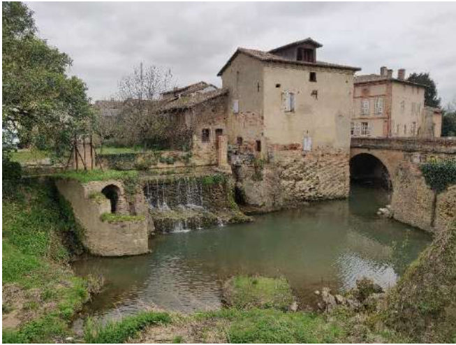
Le seuil du canal adossé au Moulin
