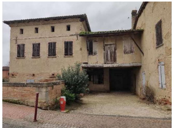
Accès du Moulin depuis la rue Marcadieu
