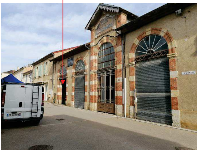
1 – Façade principale – Rue du marché
