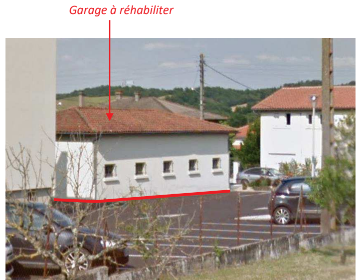
Vue 2 – Depuis l'Avenue des Pyrénées
